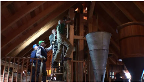
Arg eng war's für Norbert Kuhnt, Horst Geburtig, Helmut Baumgart und Dietmar Kuster beim Einbau des dritten Elevators
