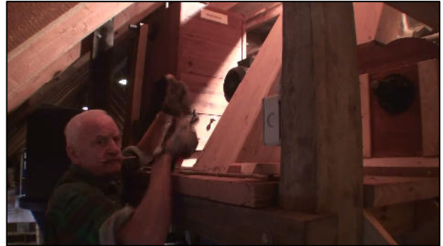
Dietmar Kuster baut den Luftkanal zum Filterwerk
