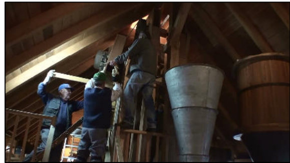
Norbert Kuhnt, Horst Geburtig und Helmut Baumgart beim Einbau des dritten Elevators
